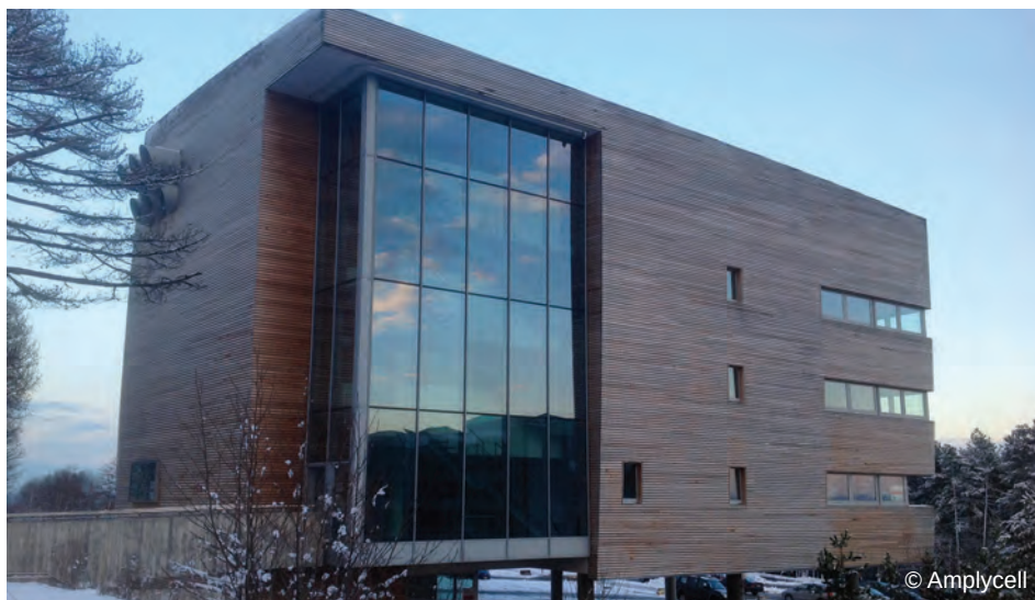
Le bâtiment à Liège de la spin-off AmPLYcell
